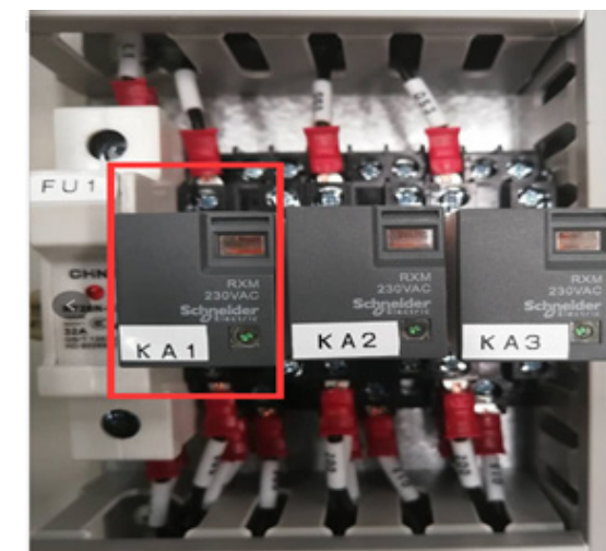
图 9 中间继电器插入底座后的实物图
