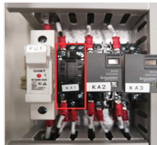
图 8 中间继电器插入底座前实物图
